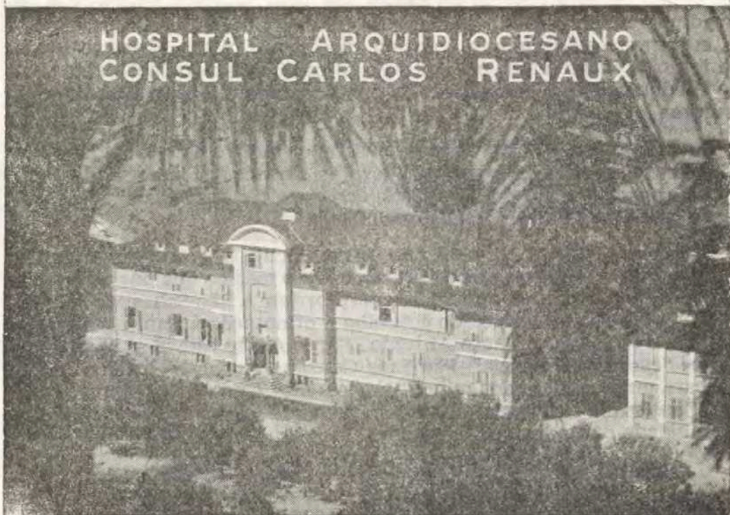
Prédio inaugurado em março de 1936 e acrescido de nova ala em 1965
